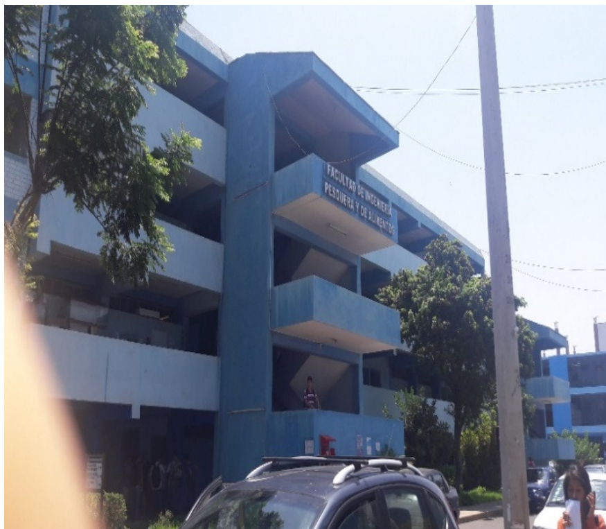
Pabellón de la Facultad de Ingeniería Pesquera y de Alimentos
