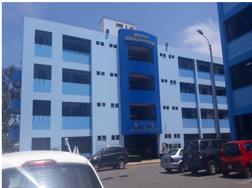
Pabellón de la Facultad de Ciencias Administrativas
